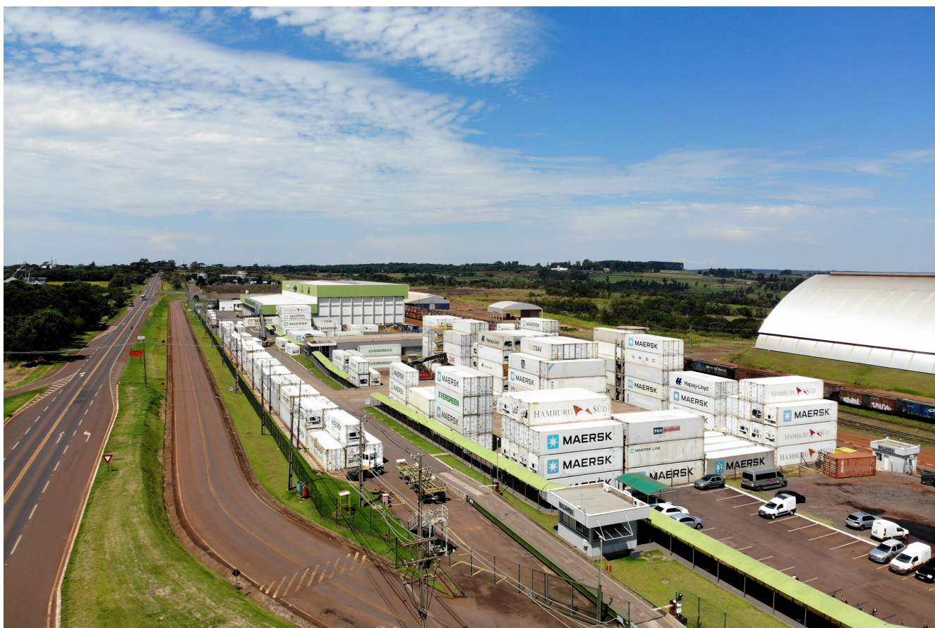
Terminal Cotriguaçu em Cascavel Foto: Gilson Abreu/AEN
